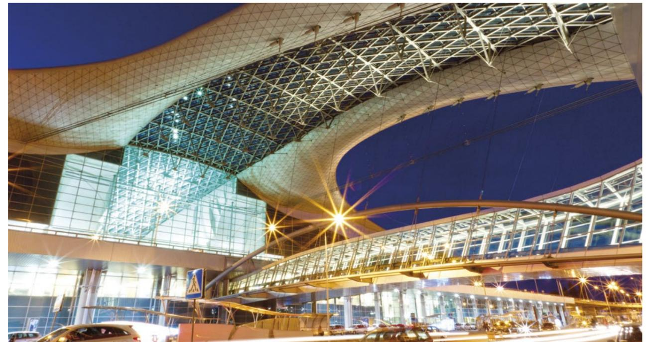
ASD0540-S / Nenngrößen M24 bis M130 unterstützen die Dachkonstruktion im Eingangsbereich des Terminals 3, Sheremetyevo Flughafen in Moskau.
