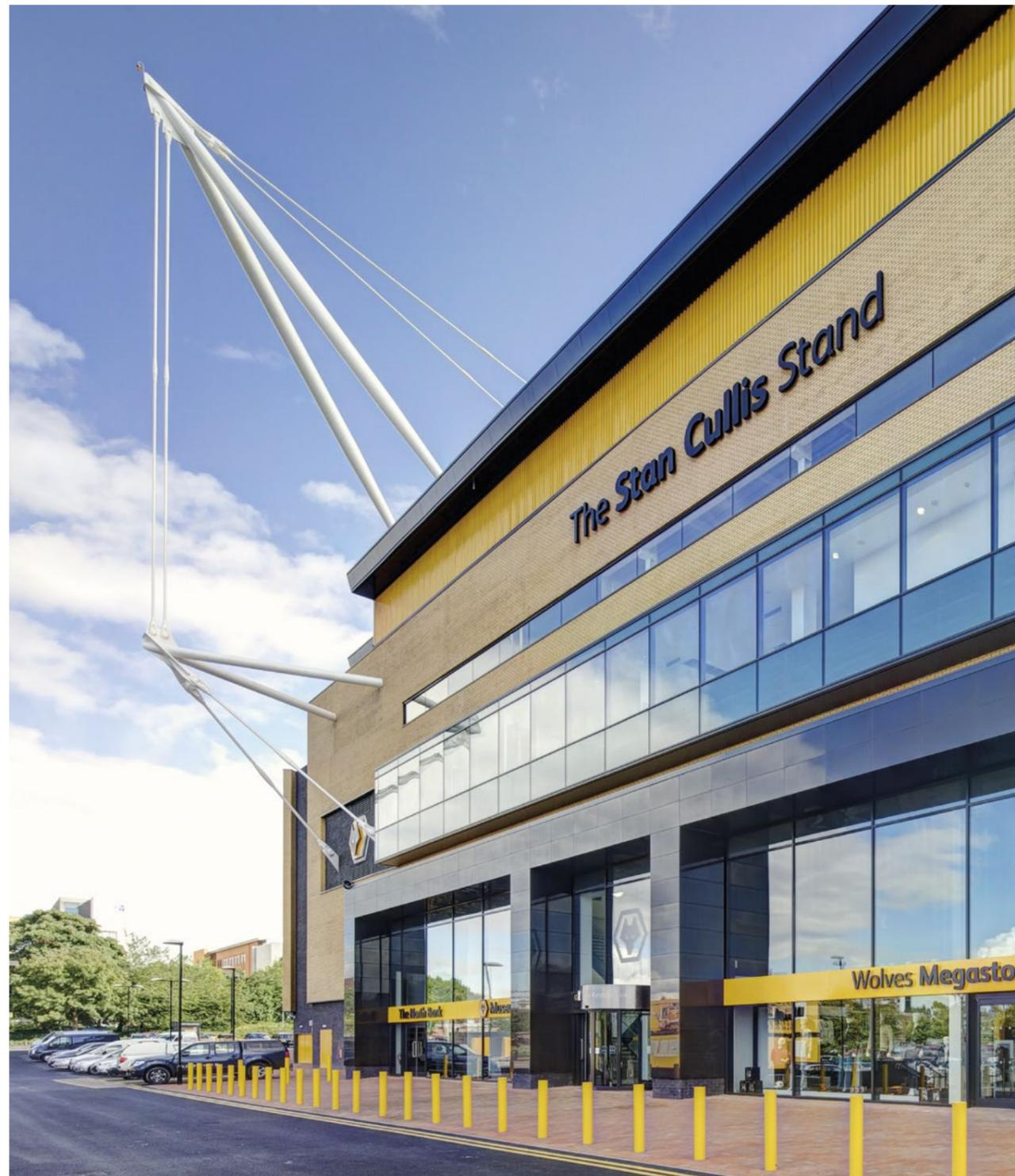
ASD0540-S / Nenngrößen M100 - M140 wurden für die Tribünenkonstruktion des Fußballstadions Wolverhampton in Großbritannien spezifiziert. Als einziges System erfüllt es die Anforderungen an große Kräfte und Vorspannung.
