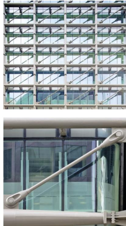
ASD0540-S / M76 bis M160 wurde als Spannelement in der Fassadenkonstruktion verbaut, um den Bau dieses einzigartigen und anspruchsvollen Bürogebäudes am Londoner Cannon Place zu realisieren.
