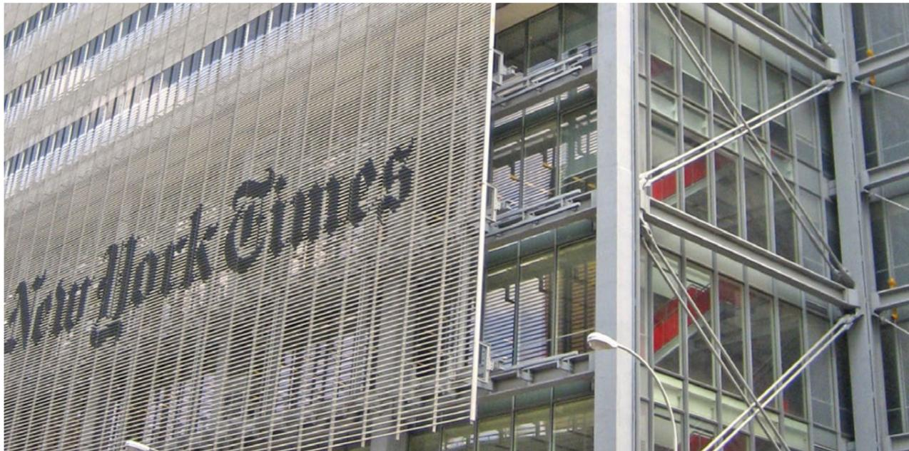
ASD0540-S / Nenngröße M76 – M100 als parallel verlaufende Kreuzverbände für das neue 52-geschossige Hauptgebäude der New York Times.
