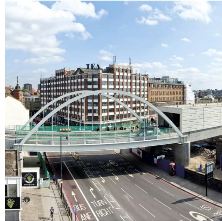
ASD0540-S / M90 als Hänger in den Brückenbögen, East London Line Railway Bridge / Shoreditch. Die Systeme müssen einem extrem hohen Anforderungsstandard entsprechen, hier unter anderem einem Dauerfestigkeitsnachweis mit 2 Millionen Lastwechseln, sowie anschließendem Bruchlastversuch.
