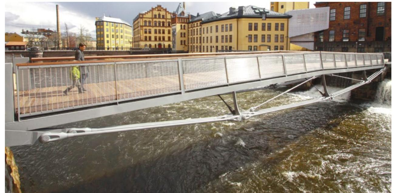
Tirants ASD0540-S M56 utilisés pour les éléments sous tension de la passerelle Kåkenhus à Norrköping en Suède.
