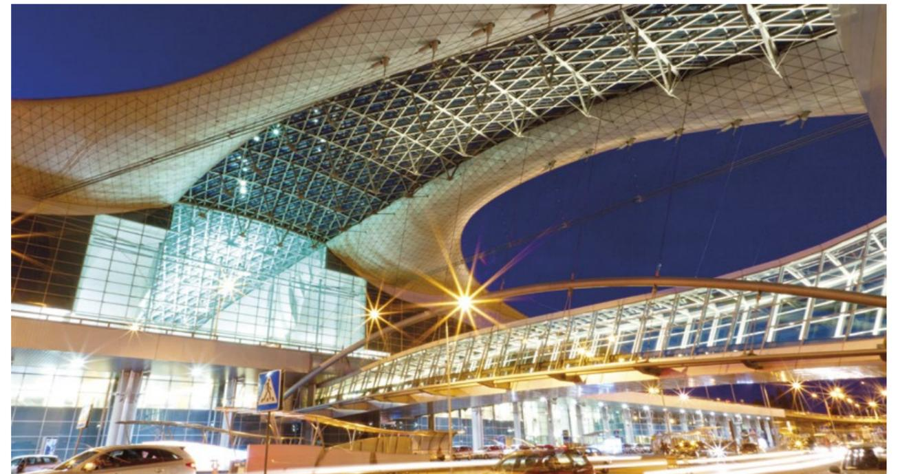
Les tirants ASD0540-S M24 à M130 sont utilisés pour soutenir la toiture de l'entrée du terminal 3 de l'aéroport Sheremetyevo à Moscou.
